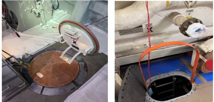
(Izquierdo) La imagen muestra una cubierta de escotilla con una cobertura adecuada. (Lado derecho) La imagen muestra el uso apropiado de una barra en forma de "U" para proteger temporalmente las alcantarillas empotradas durante las operaciones de construcción y reparación de barcos.
