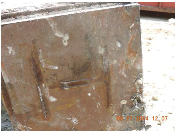
Fig. 81 – W8x40 base plate
