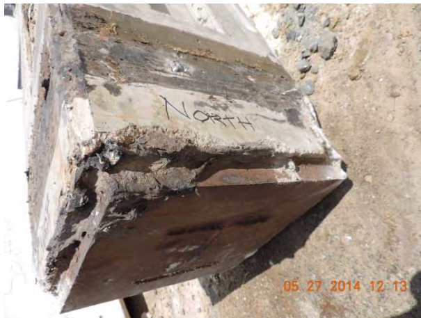
Fig. 84 – W8x40 base plate
