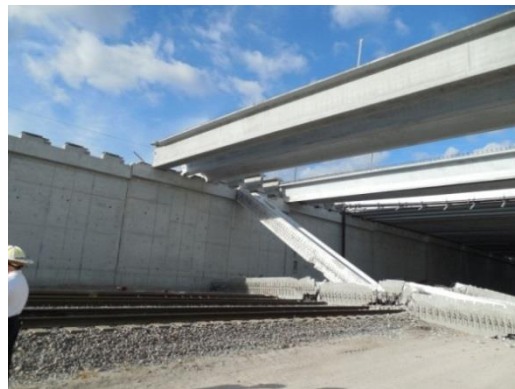
Fig. 10 Fallen beams
